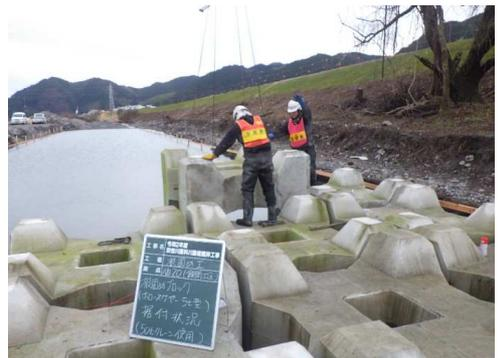
写真-16 根固めブロック据付状況
