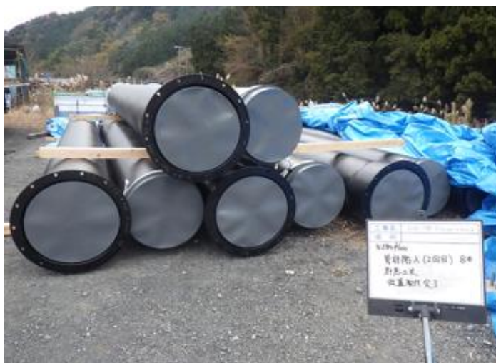
φ600送水管への仮蓋設置写真
