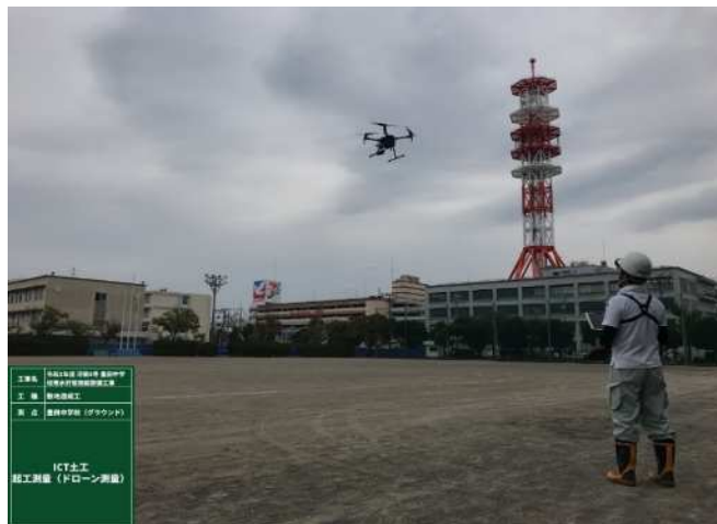
図-7 起工測量状況
