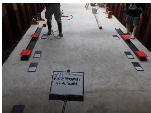
写真-3 スライドベース設置状況
