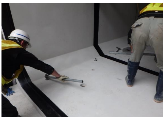
写真-4 高さ調整状況
