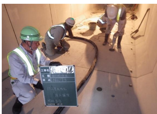
写真-5 モルタル注入状況
