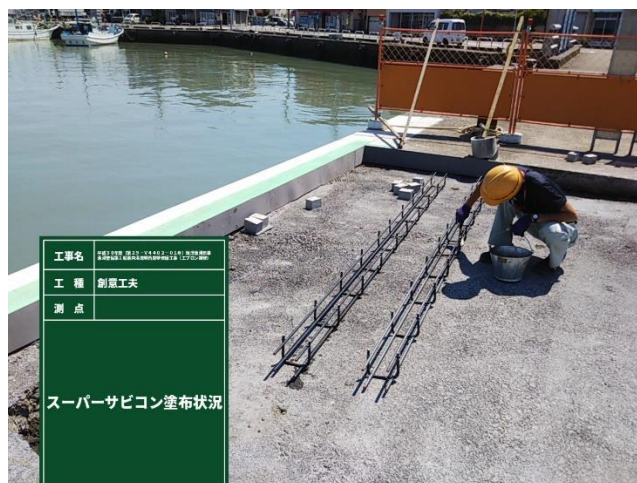
〈スーパーサビコン塗布状況〉
