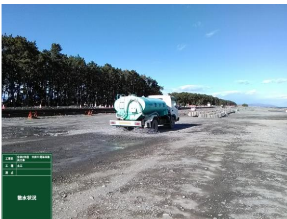
散水状況（未舗装道路）
