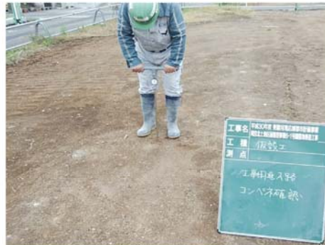
事前調査 ポータブルコーン貫入試験
