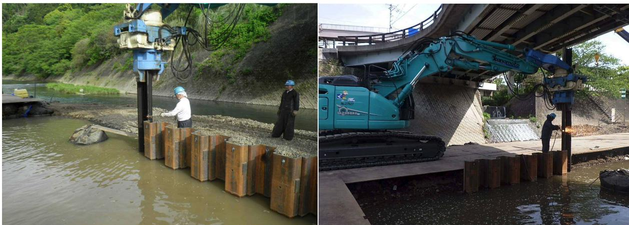
上記の施工方法により、鋼矢板の継手を減らすことで、継手の施工期間の短縮となった。
