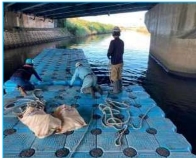
フロート台船(ピアフロート)設置完了
