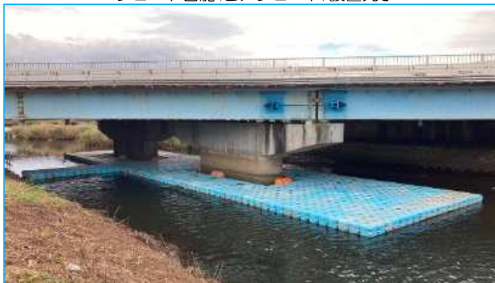
フロート台船(ピアフロート)設置完了
