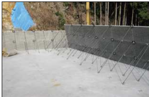
図-2 一般的な残存型枠組立状況
