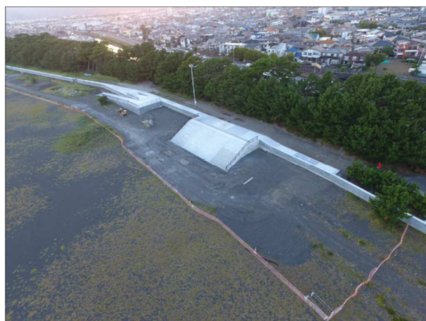
図-12 完成写真（起点から終点を望む）
