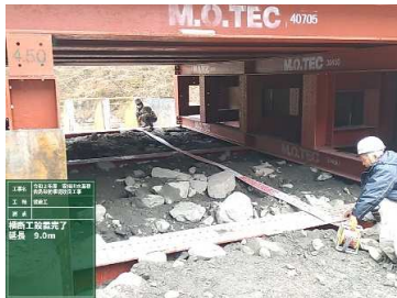
砂防堰堤内の仮締切
