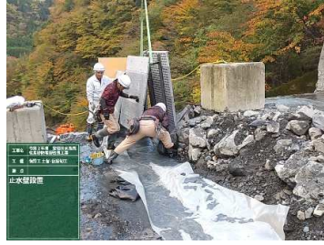
止水壁の設置
