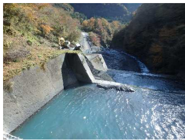
第2副堤～第3副堤間盛土
