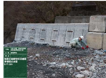
止水壁の設置
