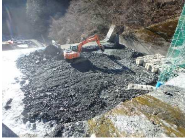
砂防堰堤内の仮締切
