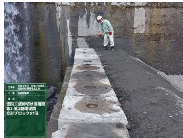
砂防堰堤内の仮締切
