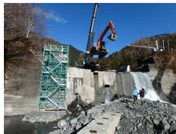
2次施工0.45m 3 バックホウ搬入
