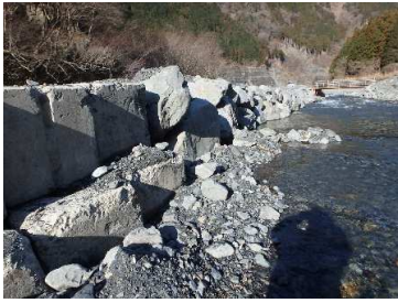
本堤上流仮締切
