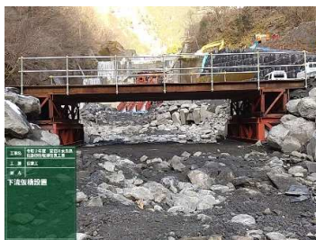
第3副堤下流仮橋
