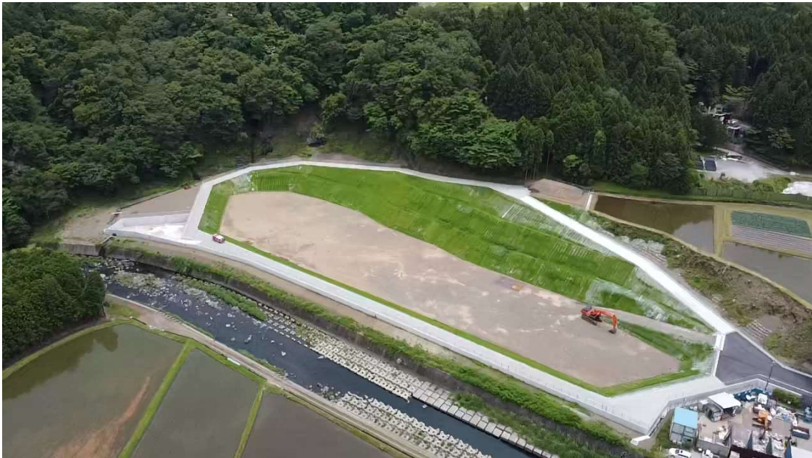
写真-3 工事完成（全景）
