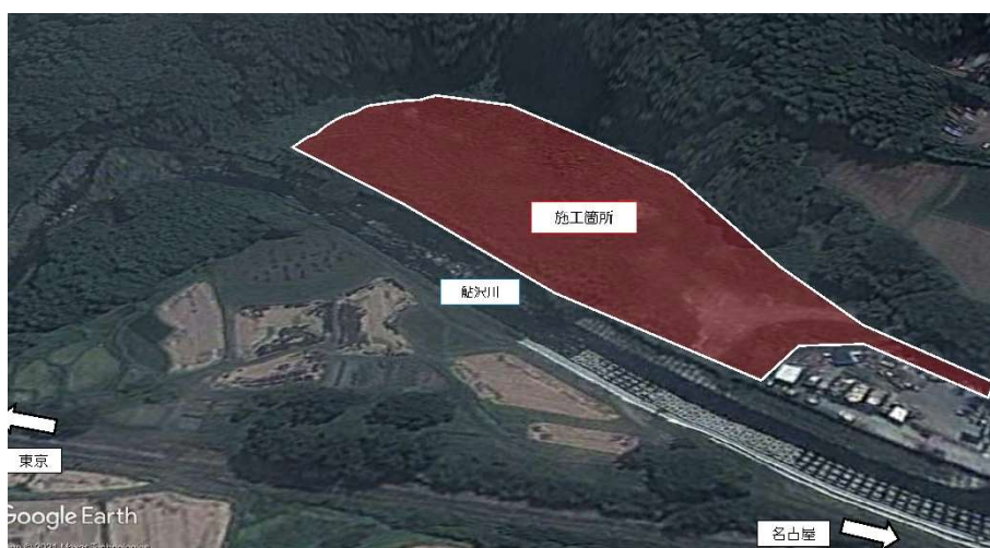
写真-1 工事箇所全景
