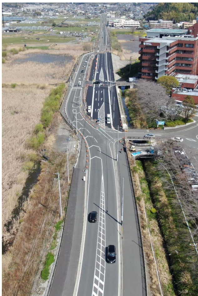
写真-1 R3.3月撮影（車線切替前）
