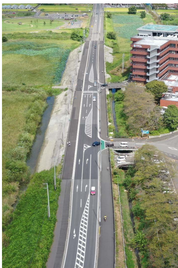
写真-2 R3.9月撮影（車線切替後：完成）
