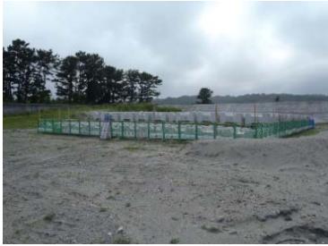
ブロック製作仮置きヤード
