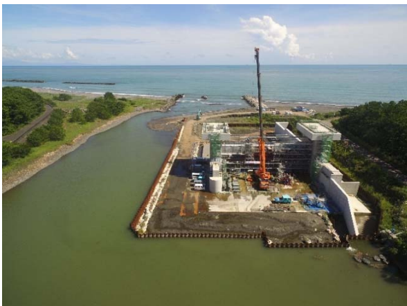
上流側からの撮影
