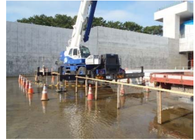
ブロック据付状況
