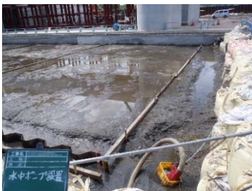
水中ポンプ設置状況
