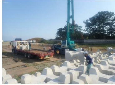
ブロック運搬状況
