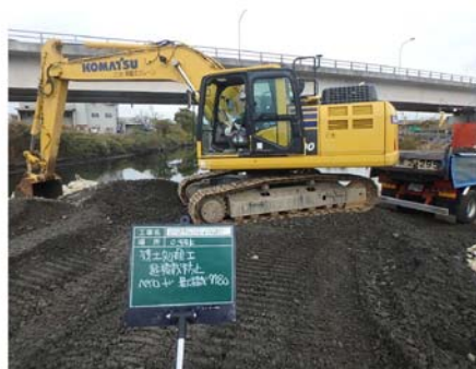
資料5, パイロード掘削機(土砂重量測定機能付きバックホウ)
