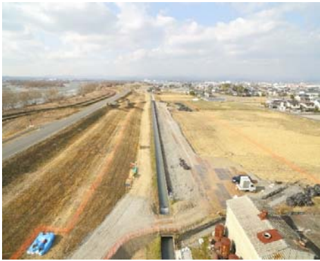
仮水路作成状況
