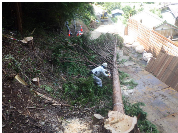
写真-4 人力での伐倒（民家側をさけて）
