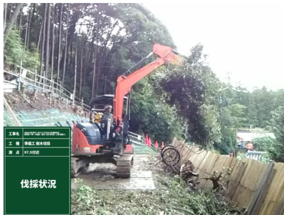
写真-4 小型バックホウにて積込
