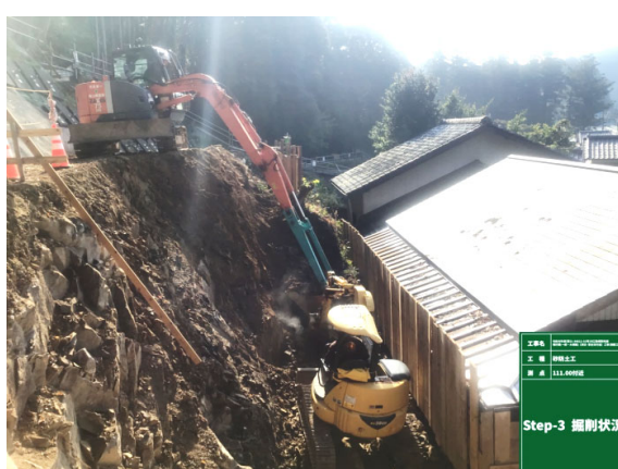
写真-7 斜面掘削状況（ステップ2・4）
