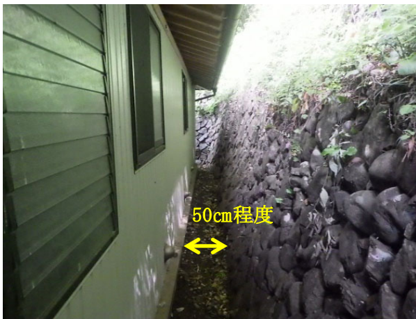
写真-2 施工箇所と民家の離隔
