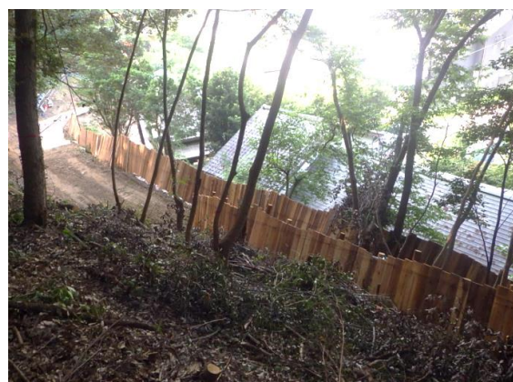
写真-6 仮設防護柵完了
