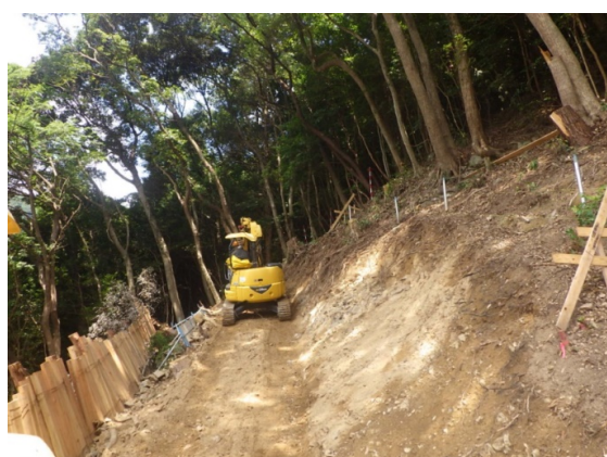
写真-7 斜面掘削状況（ステップ1）
