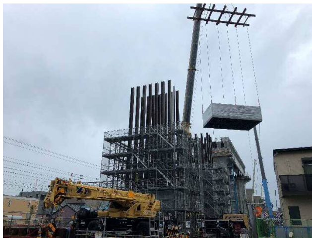
写真-5 (据付状況)
