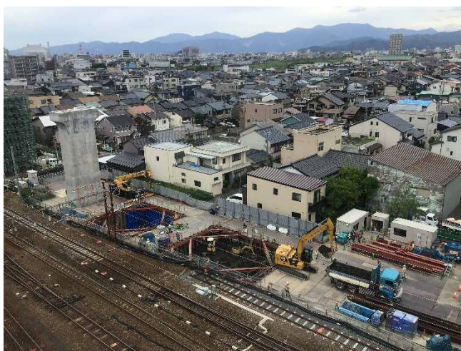
写真-1 （現場全景）
