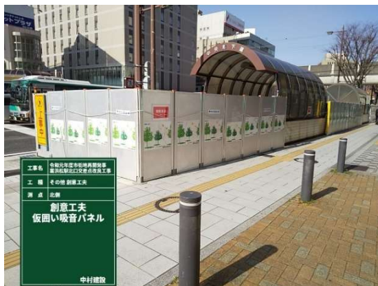
写真-7 吸音パネル
