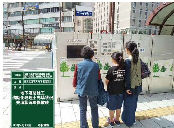
写真-8 作業ライブ映像配信状況
