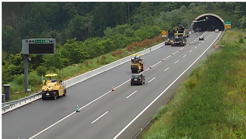
高速道路 6 車線化工事
