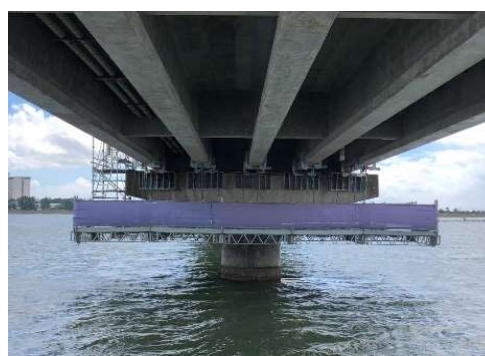
写真-2 工事施工状況
