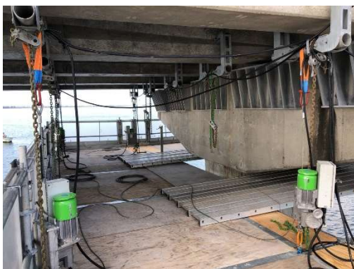
写真-5 吊足場(昇降式)
