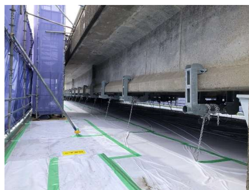
写真-6 吊足場(クイックデッキ)
