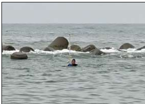
写真-4 潜水士による測量状況
