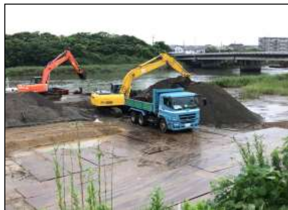
写真-3 土砂運搬状況
