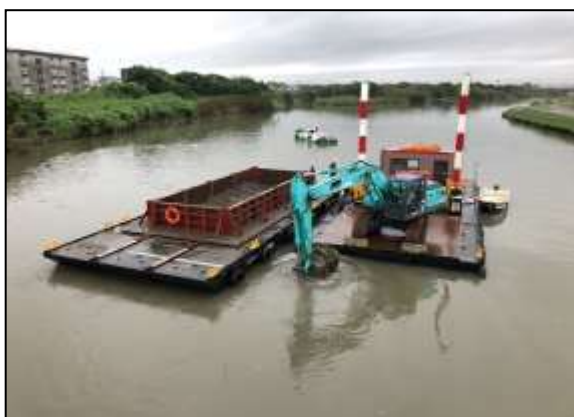
写真-2 浚渫作業状況
