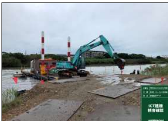
写真-7 使用した MG 機能付きバックホウ
