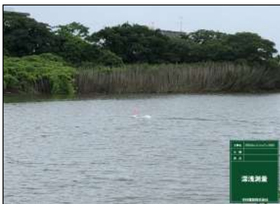
写真-6 リモコンボートによる起工測量
