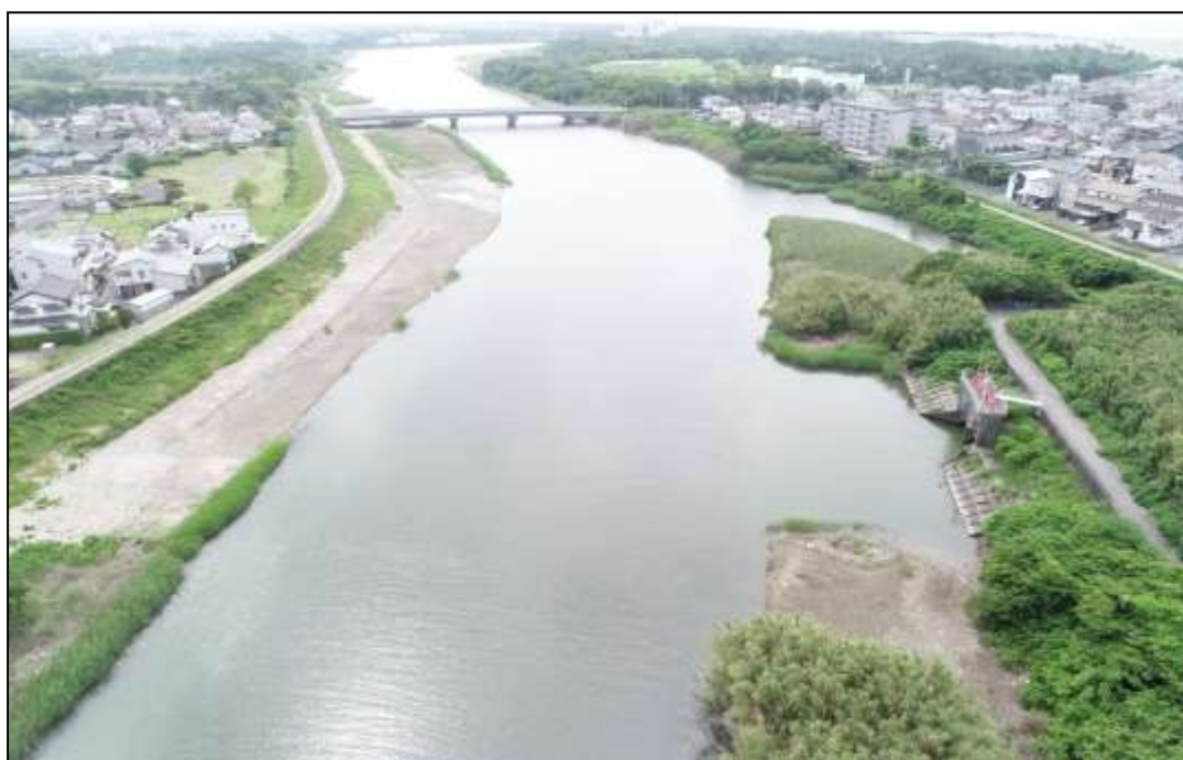
写真-1 二級河川馬込川 上流側から望む
