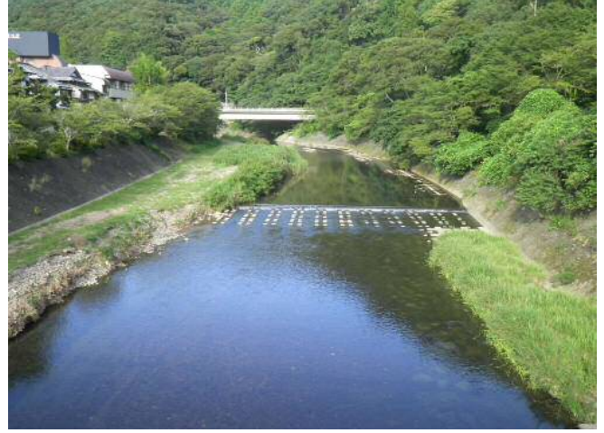
施工前(下流側より)
