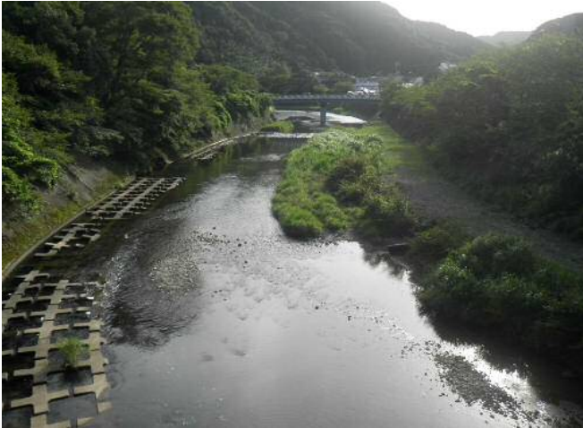
施工前(上流側より)
