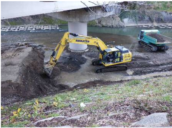
新立野橋下部付近 施工状況
