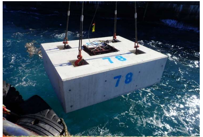
根固ブロック据付(水中ドローン映像静止画)
