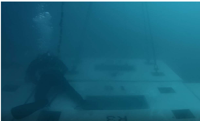
根固ブロック据付(水中ドローン映像静止画)
