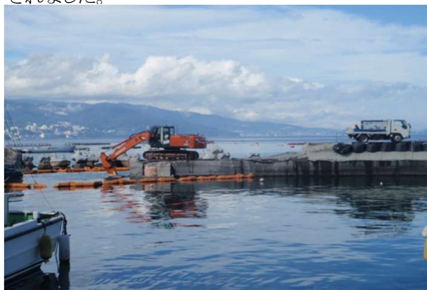
取壊し(水中)状況
