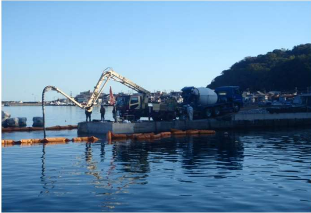
水中不分離コンクリート打設状況(遠景)
