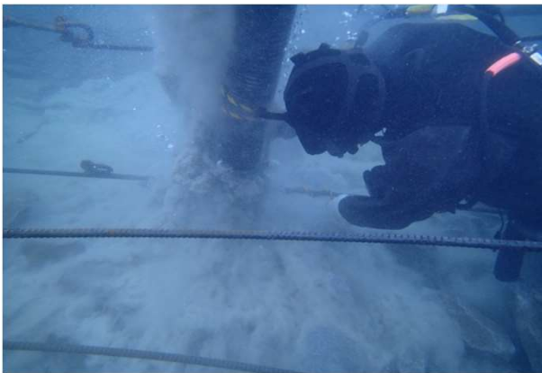
水中不分離コンクリート打設状況(水中)
