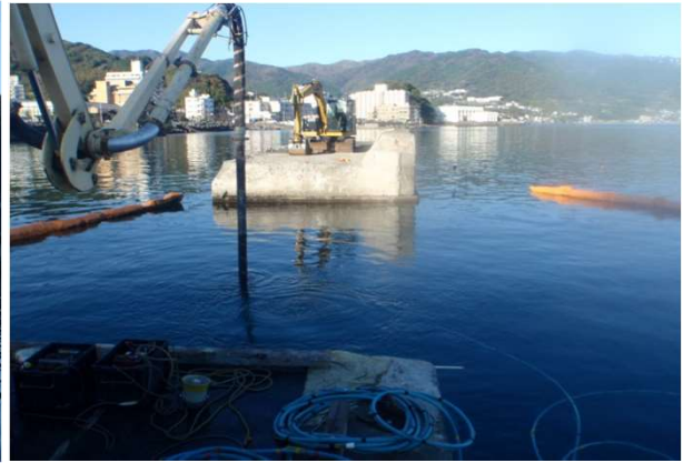
水中不分離コンクリート打設状況(近景)
