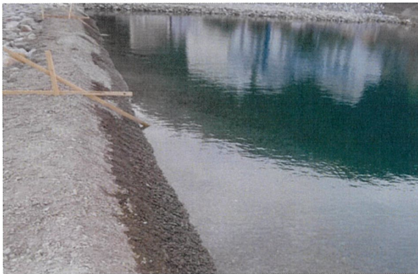
フィルター層投入均し完了 (陸上部)
