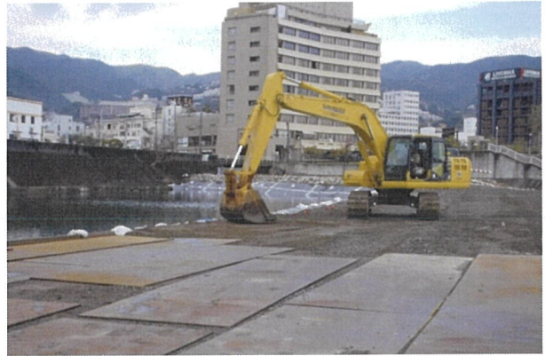
防砂シート養生状況(シート設置、碎石敷均し)
