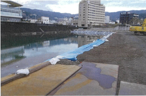
防砂シート養生状況(シート設置、碎石敷均し)
