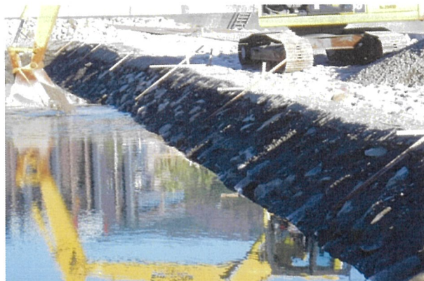
投入後日状況
