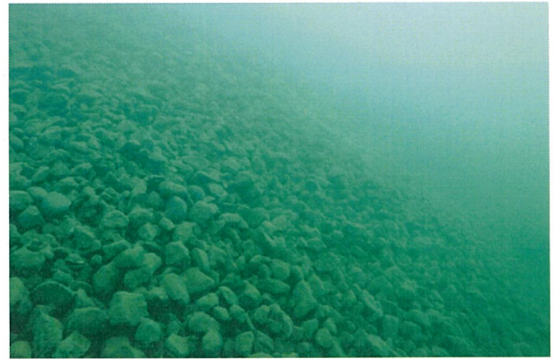
フィルター層投入均し完了 (水中部)
