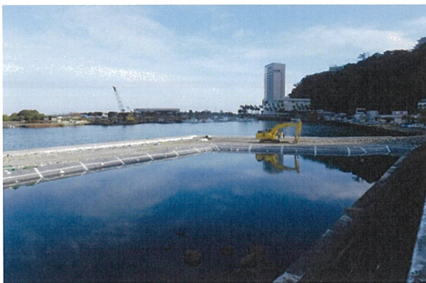
防砂シート敷設面 (水中部)
