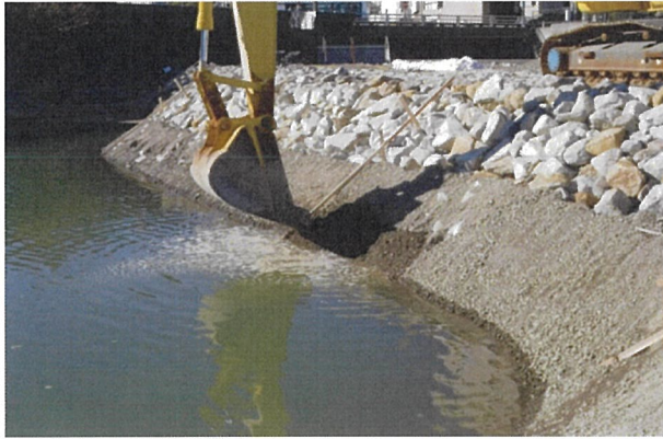
砕石投入状況
