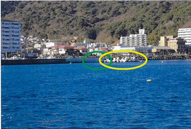
既設部分1次据付完了時
