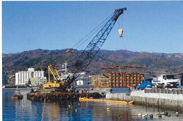
型枠吊り込み設置
