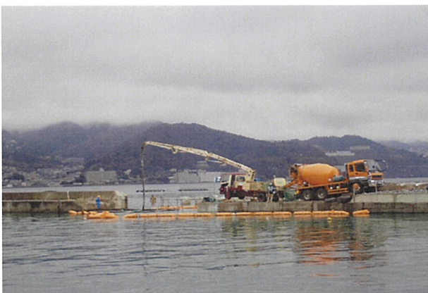
本体コンクリート打設時
