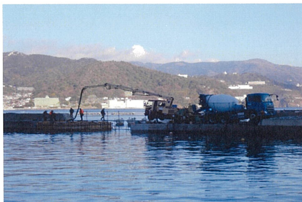
上部工打設状況
