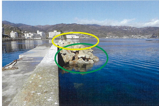
消波ブロック据付完了時
