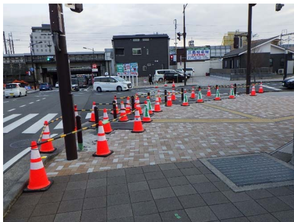
カラーコーン、ゴムマット等設置状況
