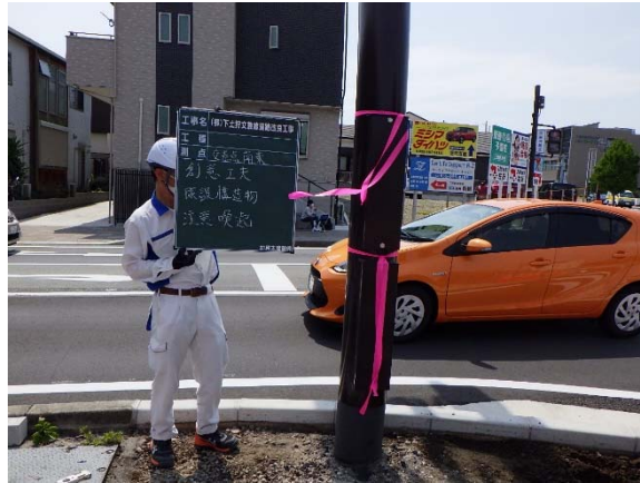
既設構造物 注意喚起状況
