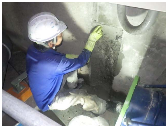
図-5 壁面補修状況
