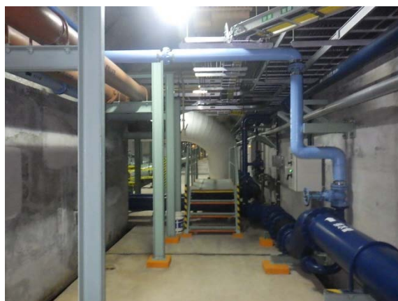
図-1 着工前状況
