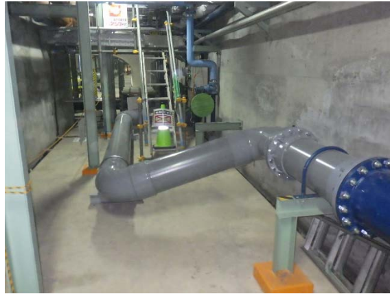
図-4 移設完了状況
