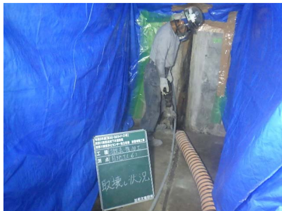
図-6 取壊し状況
