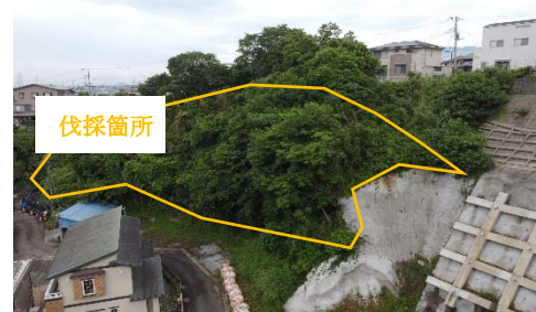
写真-1 斜面に立木がある
