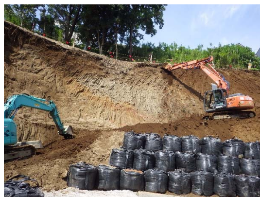
写真-6 掘削状況
