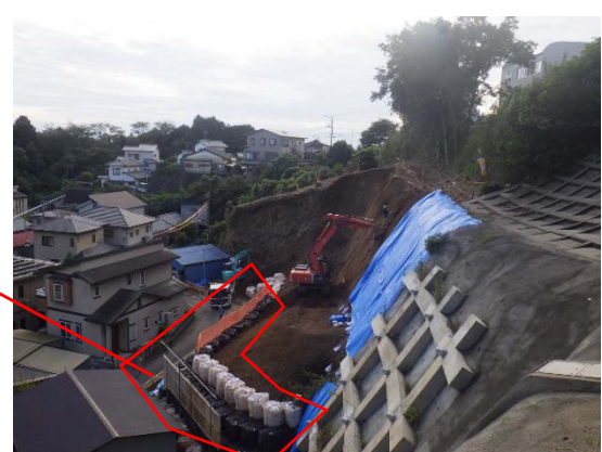
写真-9 大型土のうによる土砂の堰き止め状況
