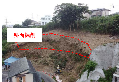
写真-2 斜面掘削時に重機走路が必要
