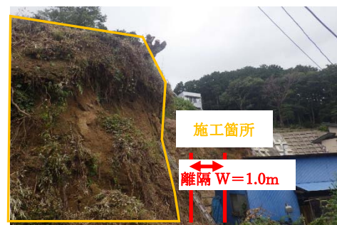
写真-3 施工箇所と民家との離隔
