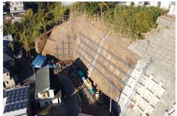
写真-10 仮設設備（無足場工法）
