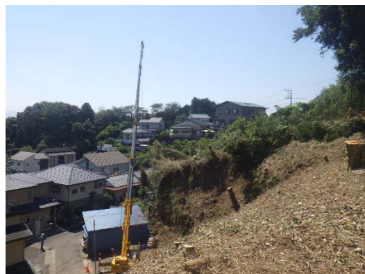
写真-5 クレーンによる集積
