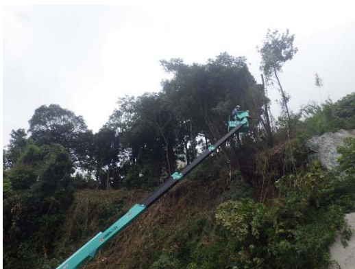
写真-4 高所作業車による伐採
