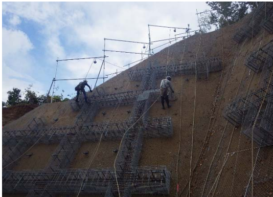
写真-9 無足場での施工状況
