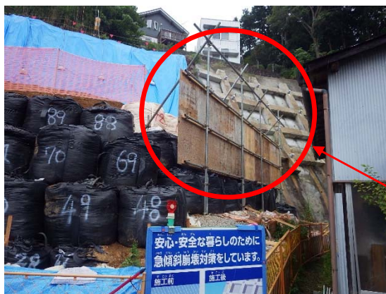
写真-8 仮設防護柵の設置
