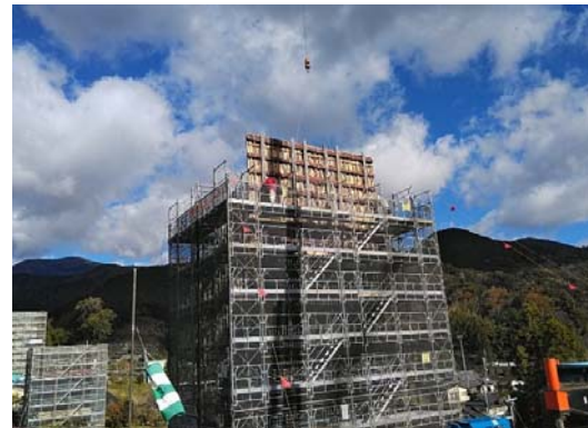
システム型枠工法 写真
