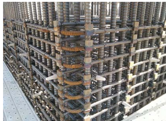
機械式鉄筋定着体 写真
