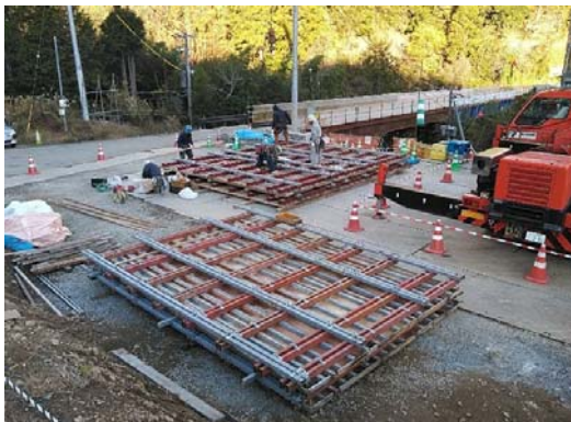
システム型枠工法 写真
