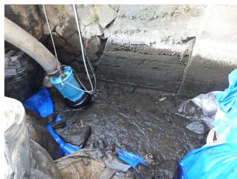
水替工（8インチ水中ポンプ）
