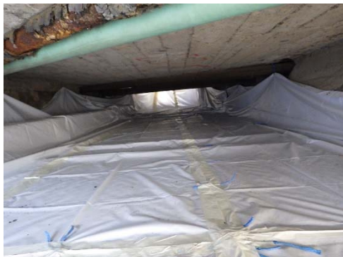
小浜橋養生状況
