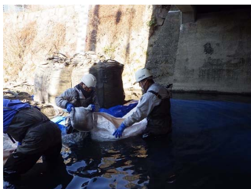
人力による仮締切工
