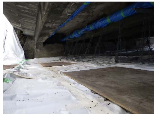
松毛橋養生状況
