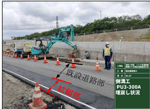
道路拡幅状況
