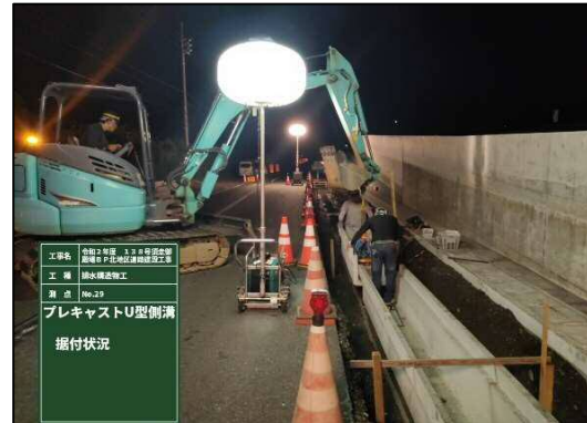
狭小部夜間施工状況
