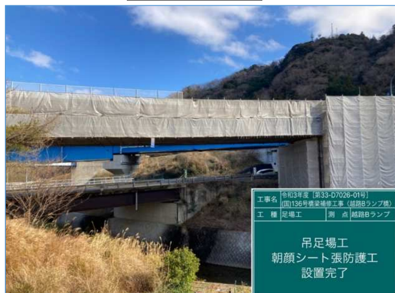
吊足場写真(河川上部)
