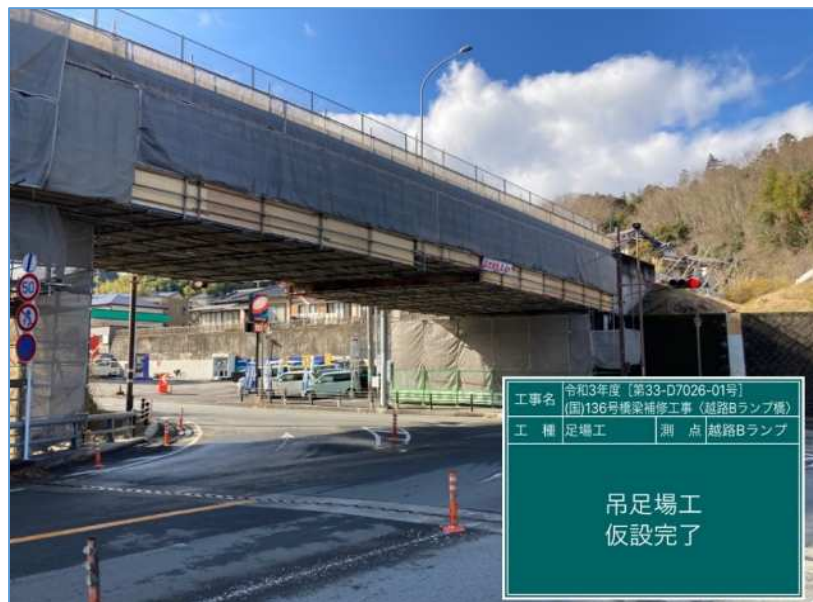
吊足場写真(県道交差点部)
