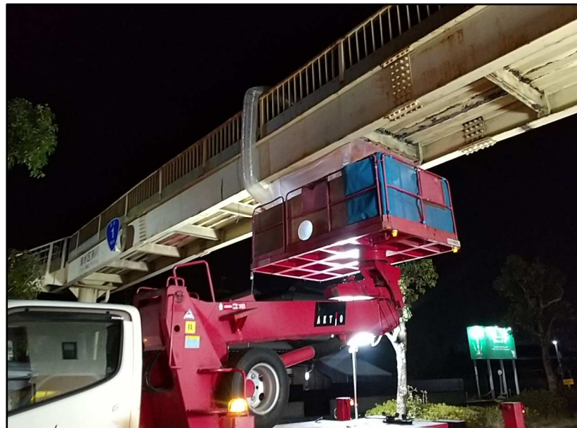
高所作業車による作業足場の確保
