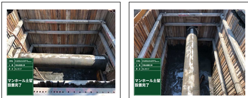
写 5. マンホール土留設置完了
