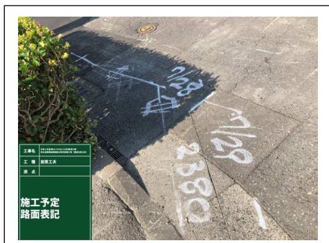
写 3. 施工予定路面表記
