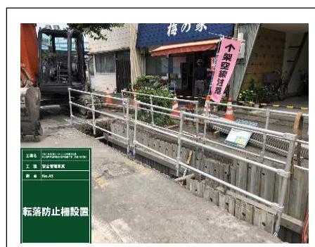
写 4. 転落防止柵設置(歩車道側)
