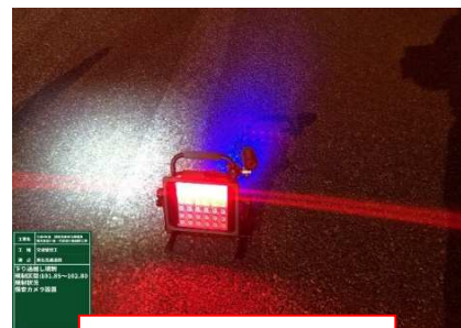
設置状況：施工箇所周辺
