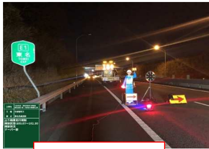
設置状況：テーパー部
