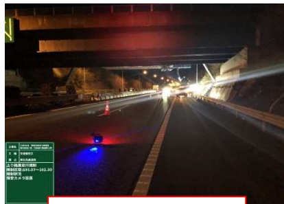
設置状況：施工箇所周辺
