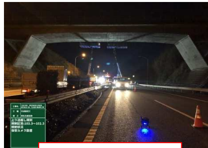
設置状況：施工箇所周辺
