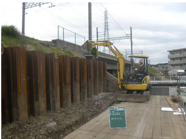
(下り線側) バックホウ作業状況 (写真-7)
