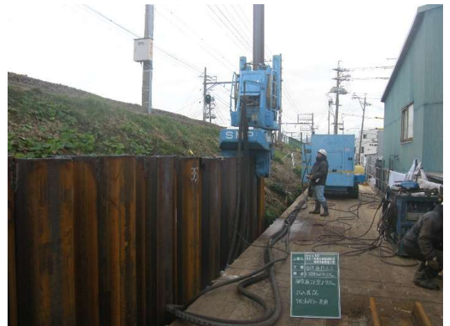
(下り線側) 鋼矢板挿入状況 (写真-6)
