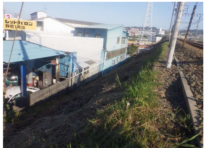
着手前：下り線側
