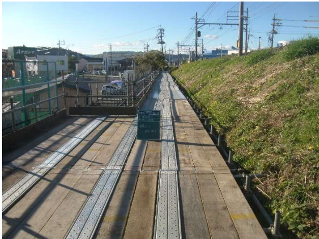
(上り線側) 単管仕様の作業床設置状況 (写真-3)
