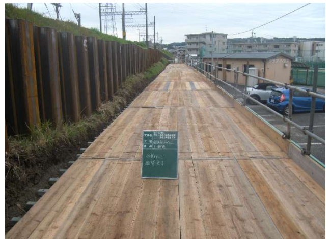
(下り線側) TSサポート仕様の作業床設置状況 (写真-4)
