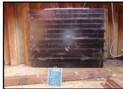
写真-2 バックロック組立完了
