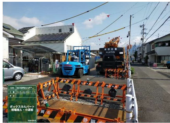
写真4 問題点②対策写真
