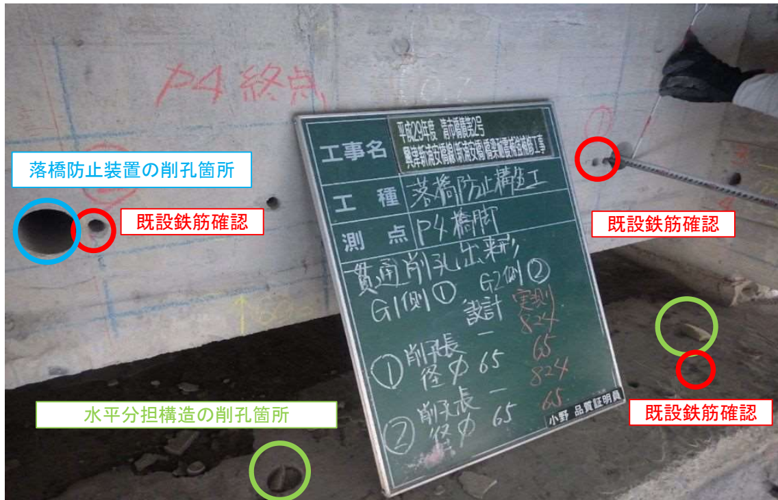
落橋防止設置箇所コア削孔完了（P4橋脚）（参考）
