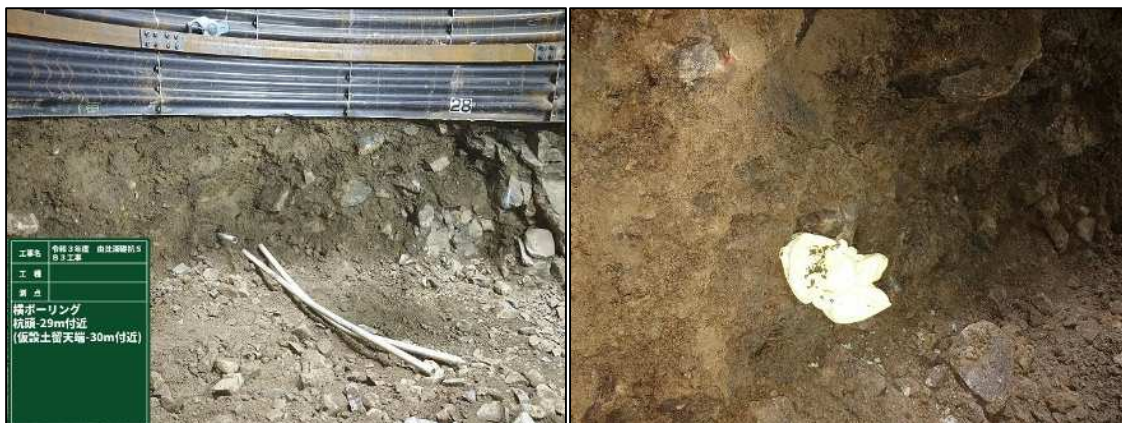
〈写真1〉横ボーリング露出状況
