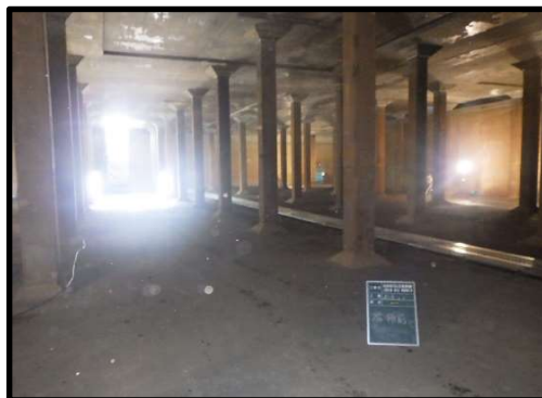
配水池内部（着手前）
