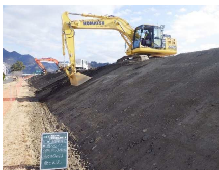
写真－10 法面整形状況
