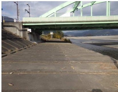
写真-6 安倍川橋桁下①
