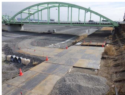
写真-8 工事用道路設置完了
