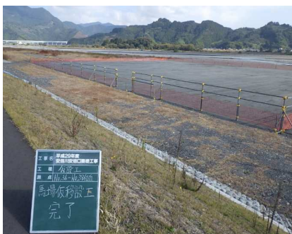
写真－３ 馬場移設完了
