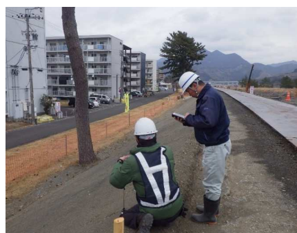
写真－11 出来形立会状況
