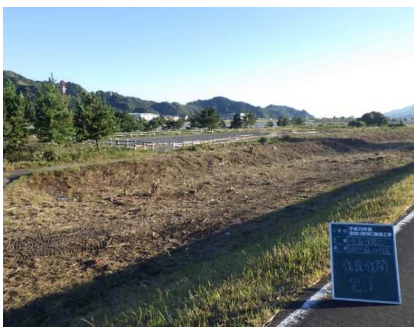
写真－４ 伐採完了
