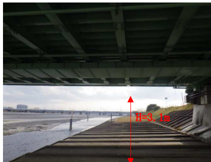
写真-7 安倍川橋桁下②
