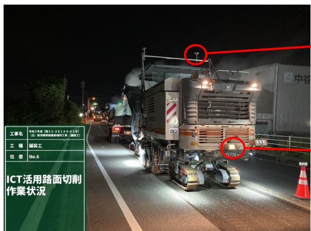
写真-3 MC路面切削機作業状況
