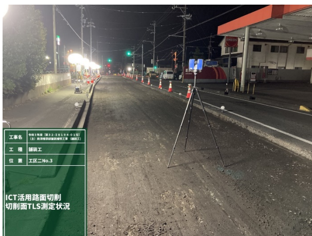
写真-2 TLSによる出来形測定
