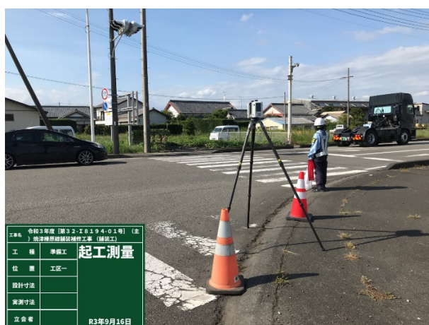
写真-1 TLSによる起工測量
