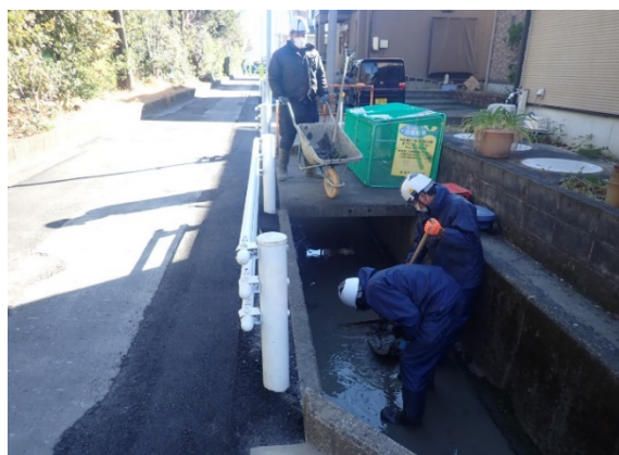
【用水路清掃状況】
