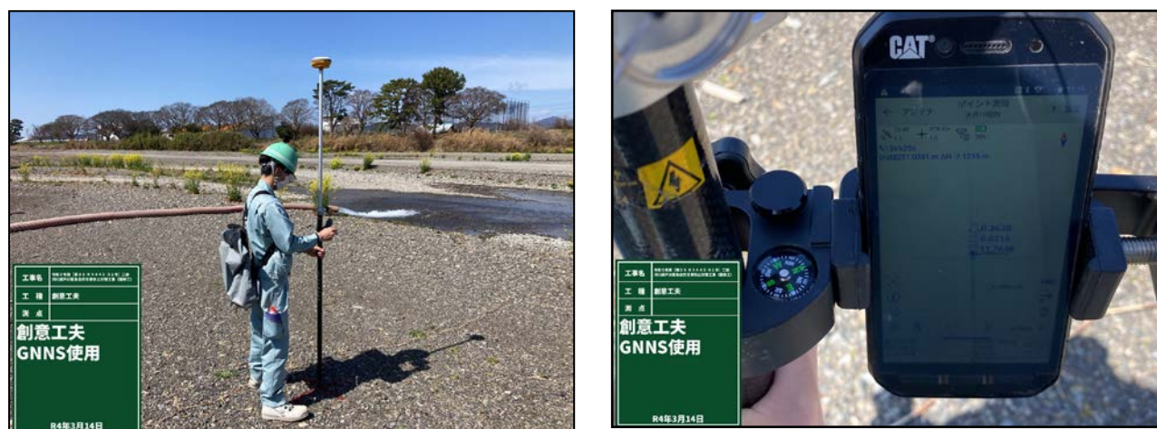
(写真 2-2) GNSS 採用
