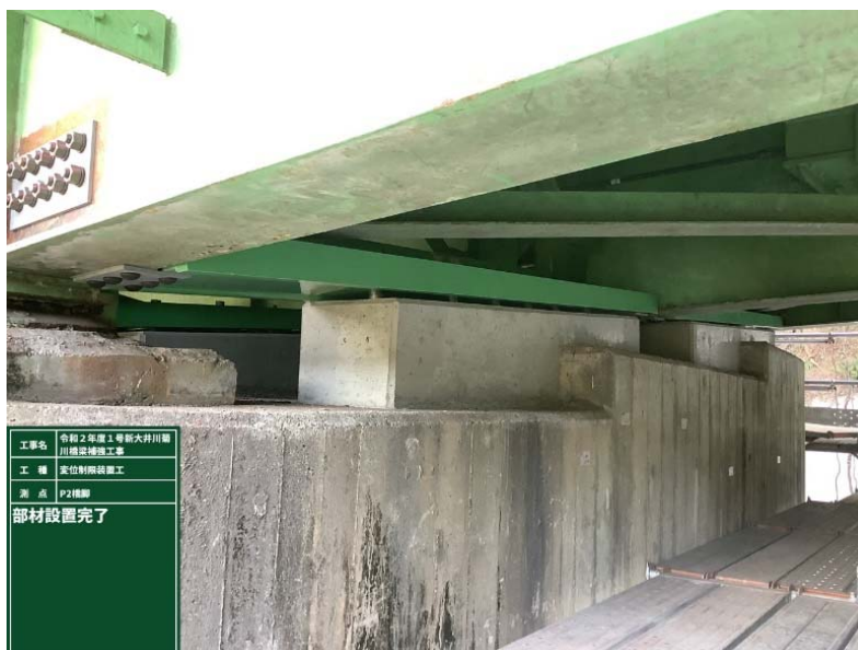
足場内の様子
