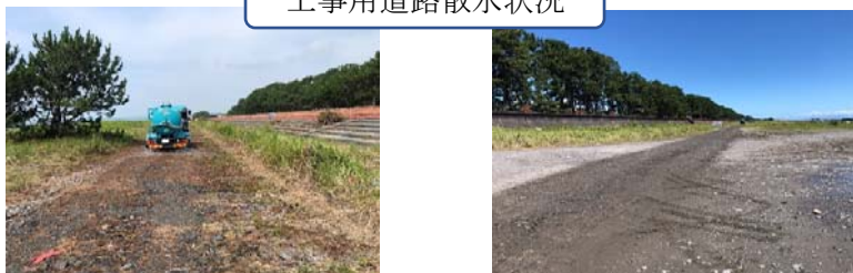
工事用道路散水状況
