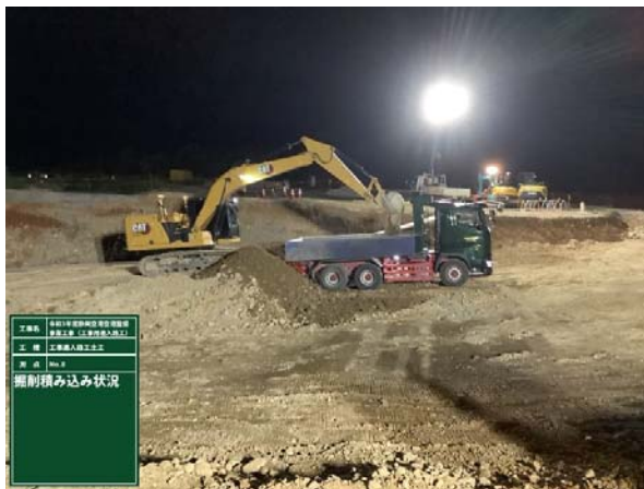
夜間 ICT 掘削積み込み作業
