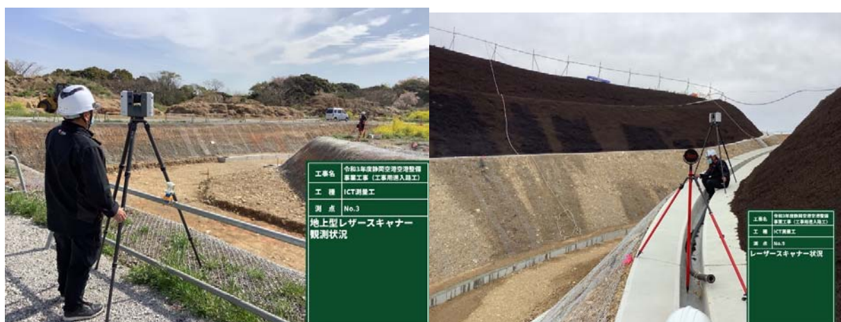
掘削完了後のレーザーキャナによる出来形確認
